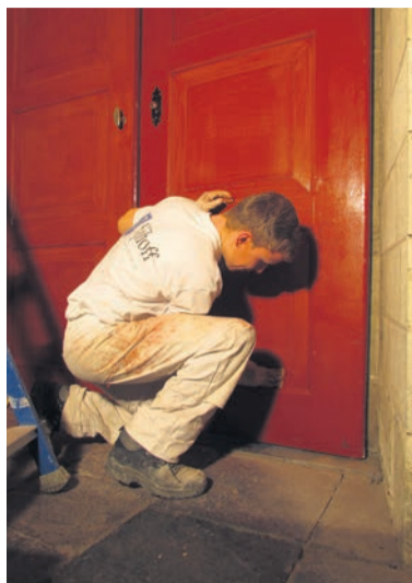
Leerling Bert Boogert schuurt de achterzijde van de monumentale voorportaaldeuren
